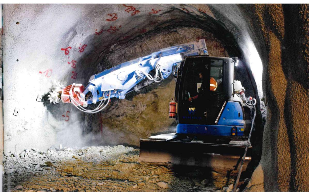
Seit September 2021 ist der erste eBadger der Firma Wimmer im Dauertest-Einsatz im ZaB. Der Antrieb des Baggers läuft über einen Elektromotor, der eine Leistung von bis zu 50 kW liefert. Während des Arbeitsprozesses ist der eBadger an das Stromnetz angeschlossen.
